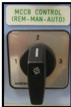
Рисунок 7-1. Переключатель режимов управления MCCB (-S6)
