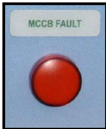
Рисунок 7-5. Индикатор MCCB FAULT
